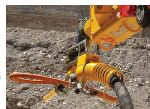
Shotcreting device for installation of steel arches for installation of rails, etc. Spritzbeton Manipulator zum Einbringen von Ausbauelementen zum Einbau von Schienen etc
